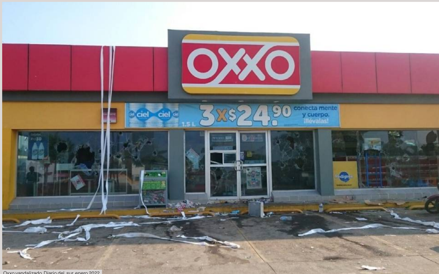
Oxxo vandalizado. Diario del sur, enero 2022
